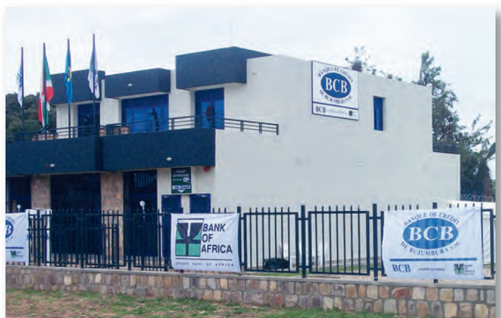
Façade de l'Agence de Rumonge rénovée. Main facade of the renovated Rumonge Branch.
